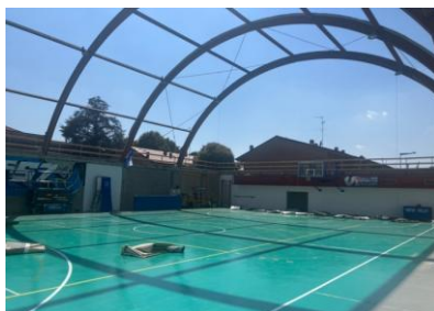
La struttura della palestra senza copertura
